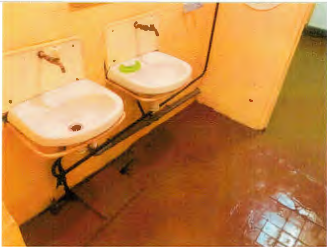
Фото №27 – Санитарно-гигиенические помещения
