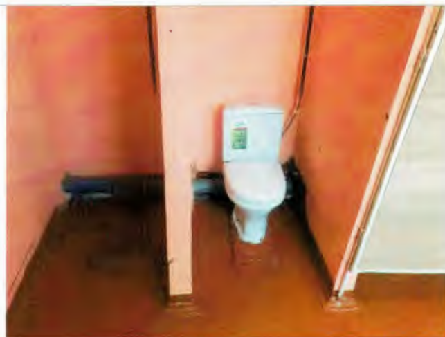
Фото №32 – Санитарно-гигиенические помещения
