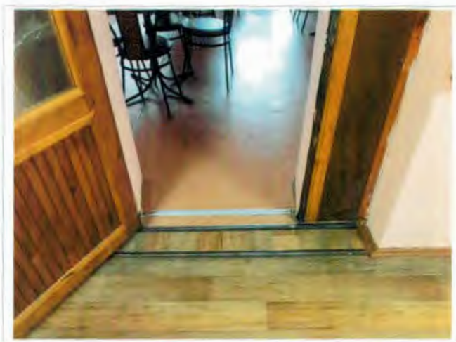
Фото №16 – Пути движения внутри здания (двери)
