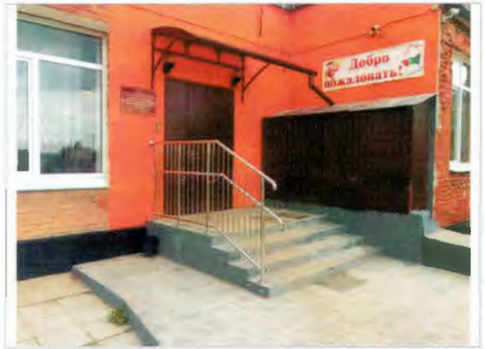
Фото №8 – Входная площадка главного входа
