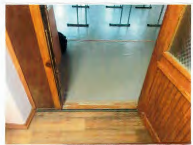
Фото №18 - Пути движения внутри здания (двери)
