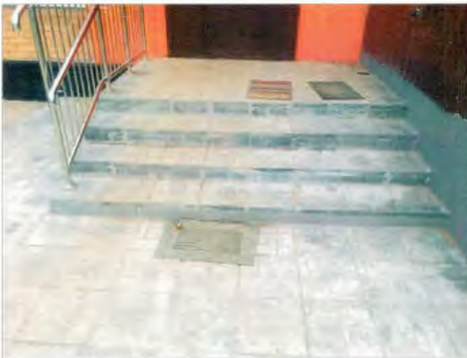
Фото №9 – Наружная лестница главного входа
