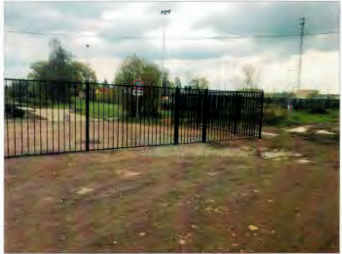
Фото №2 – Подходы к объекту
