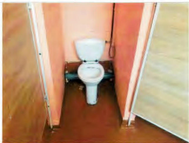
Фото №31– Санитарно-гигиенические помещения
