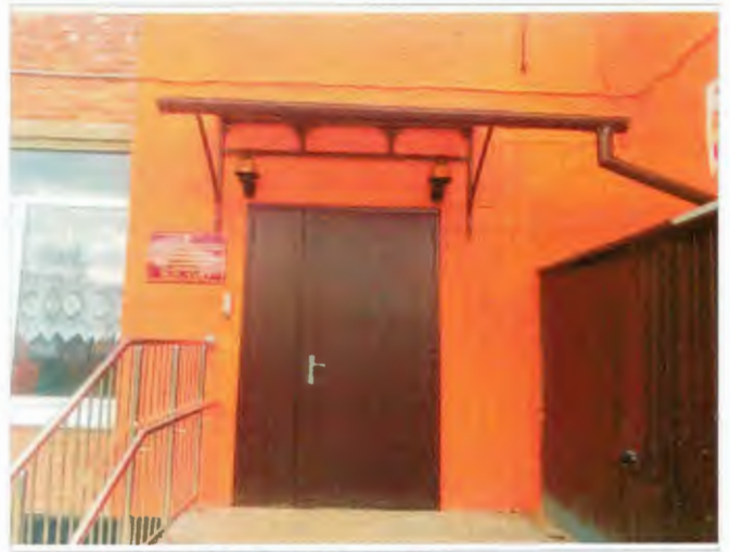
Фото №10 – Входная площадка главного входа
