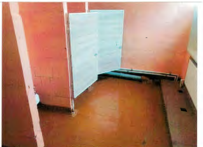
Фото №30 – Санитарно-гигиенические помещения
